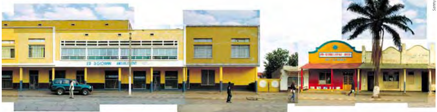
L'Avenue de la Mine à Likasi au Congo s'expose à l'entrée de l'hôpital, sur l'esplanade.
